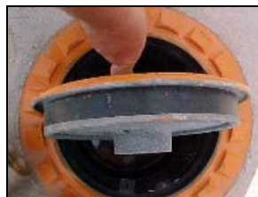
Spill bucket lid gasket
